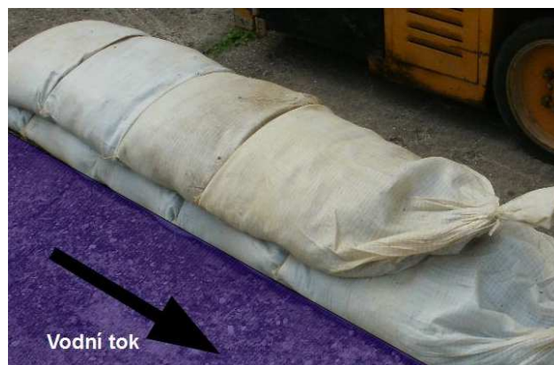
Jednořadé kladení pytlů podélně
