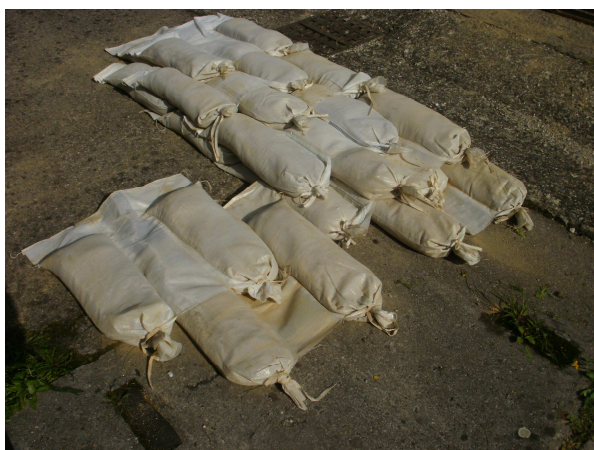
Umístění hráze z dvoukomorových pytlů
