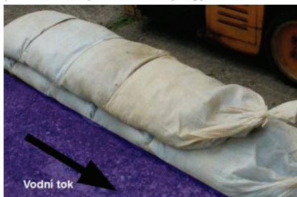
Jednořadé kladení pytlů podélně
